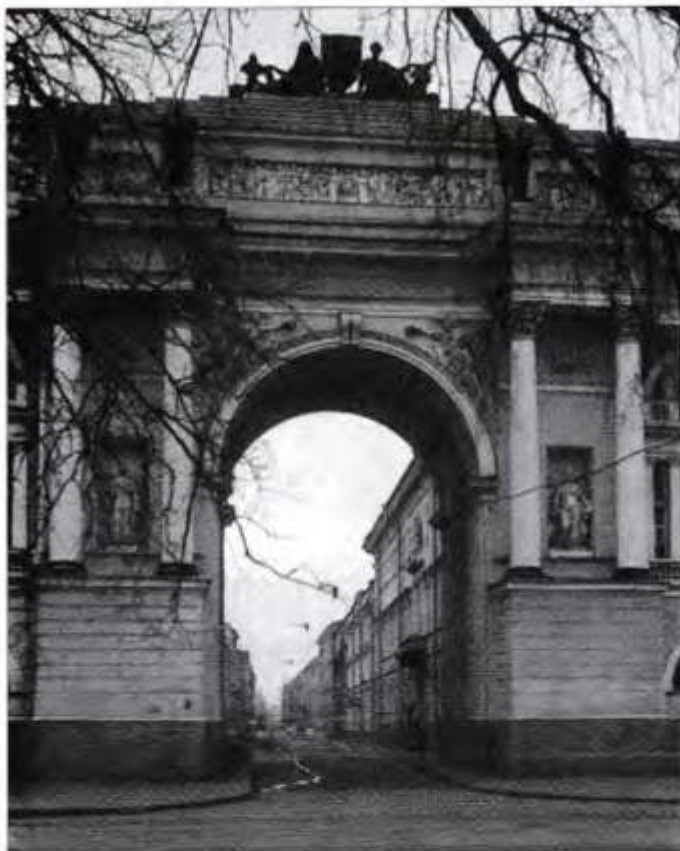
Здание Сената и Синода
